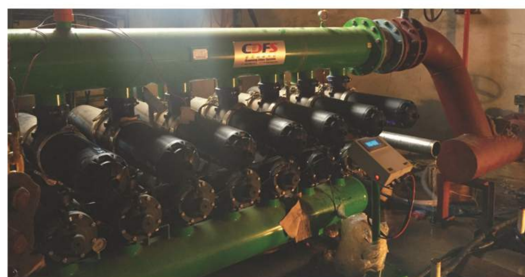
水源热泵冷却水过滤
